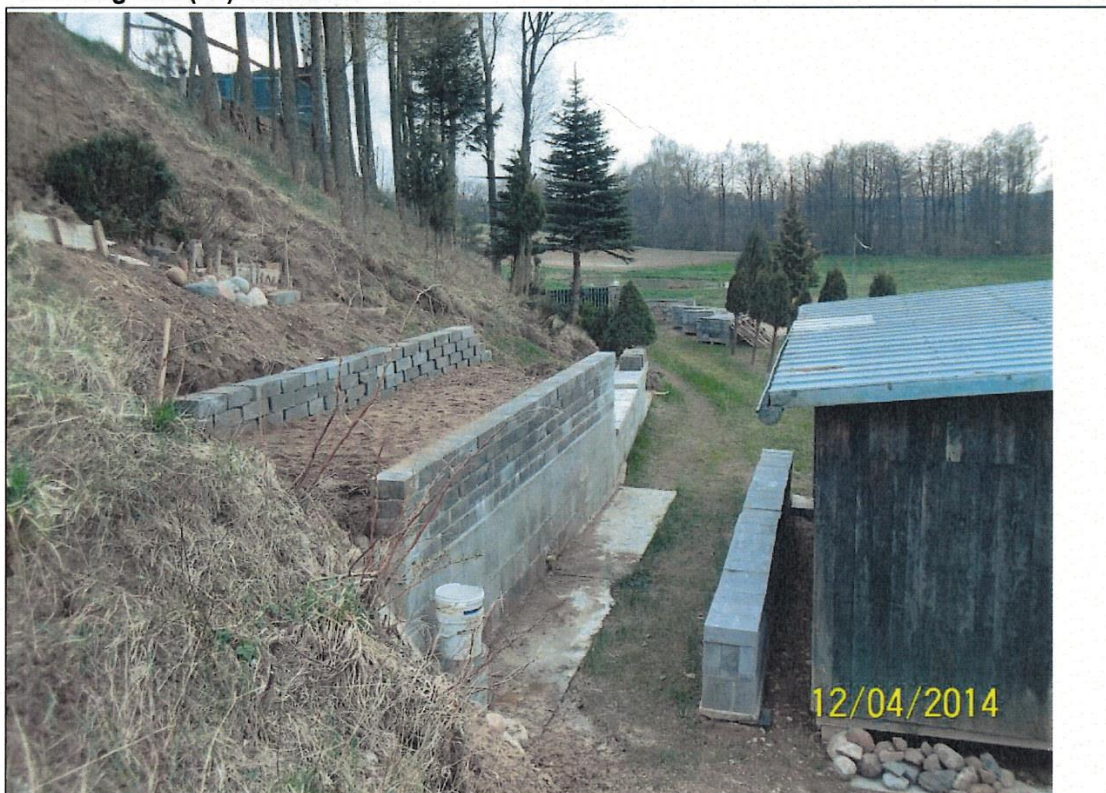
Foto 6. Efekt prac zabezpieczających zakończonych w kwietniu 2014 r. (zdjęcie udostępnione przez właściciela działki)
